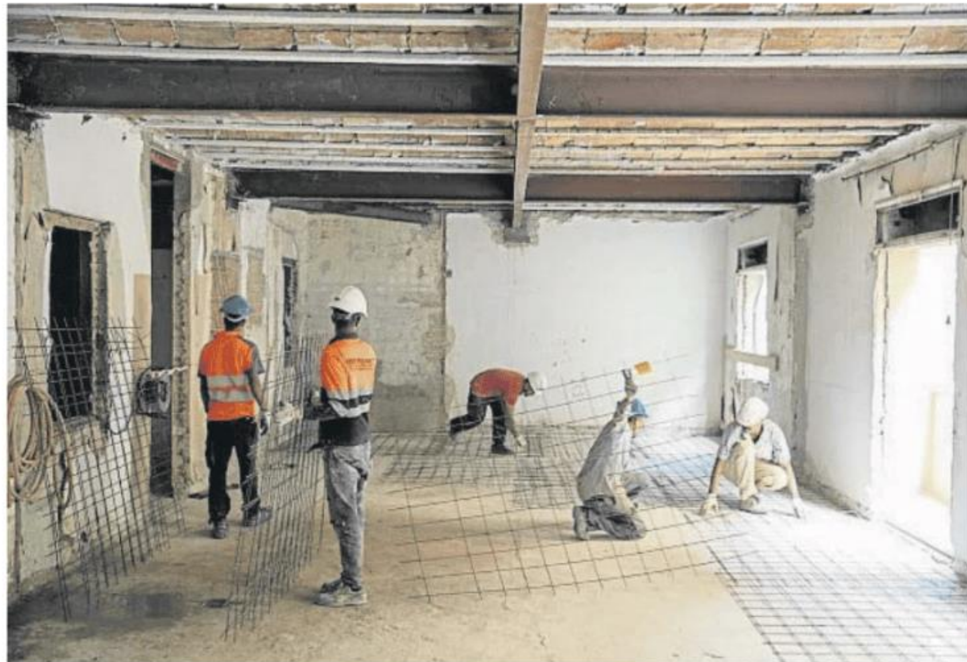
Unos cuantos operarios trabajando, ayer mismo, en este edificio del paseo Joan de Borbó
