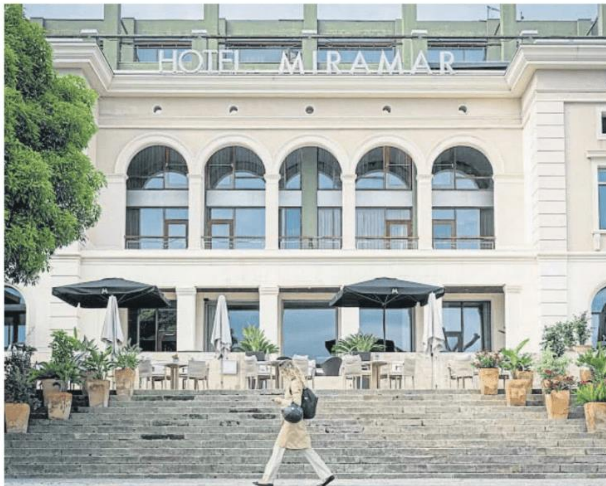
En el piso noble, tras la terraza de la fachada principal, se incorporará un nuevo restaurante
